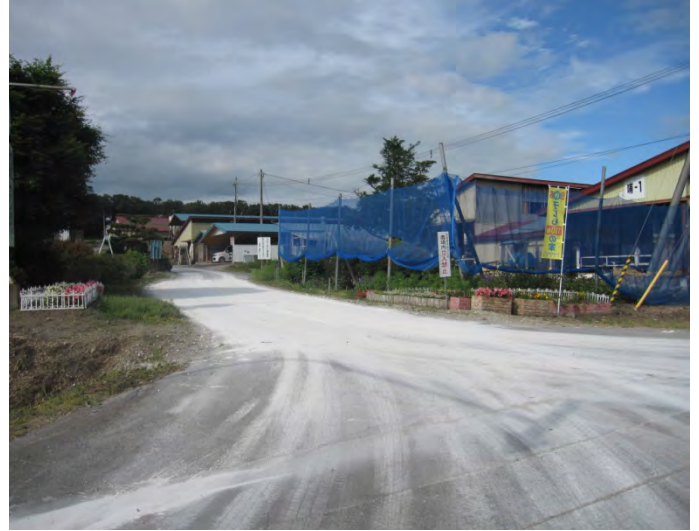
消石灰帯の設置
