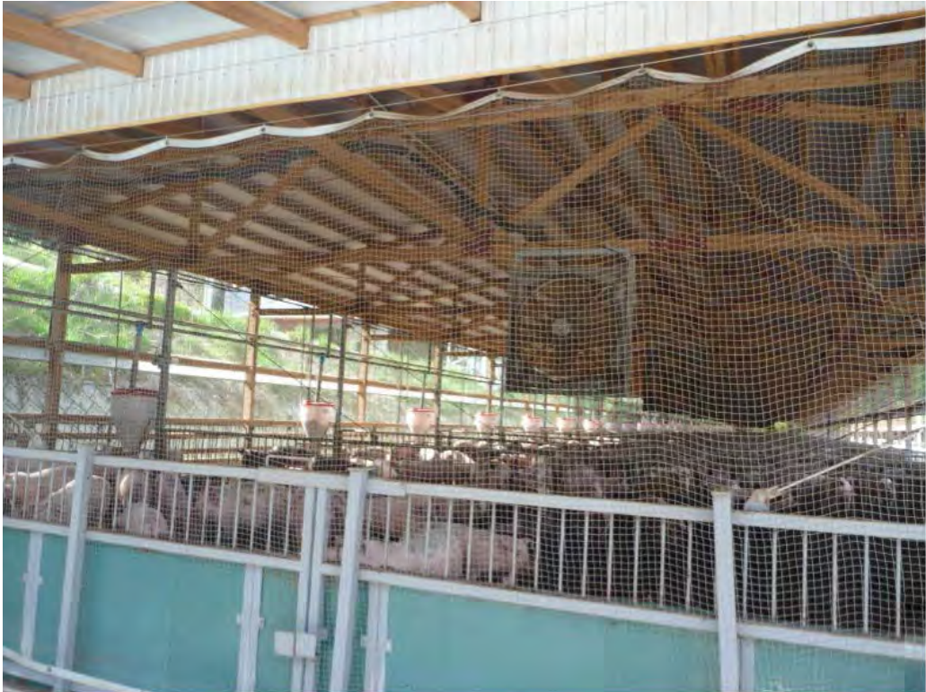
野生動物侵入防止用のネットの設置例
